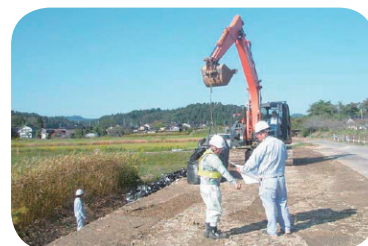
地震災害復旧工事現場
