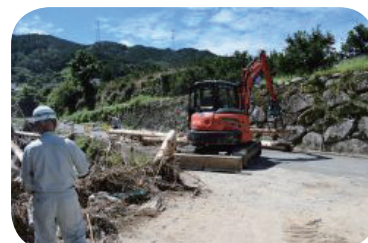
大規模地滑り災害復旧工事現場
